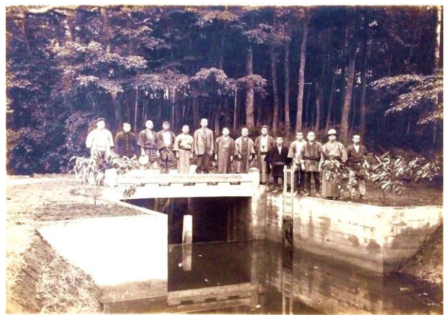
昭和11年 分水堰の完成
