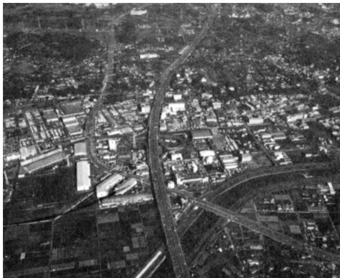
港北インターチェンジ
