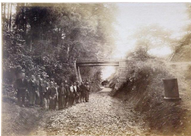
昭和9年 灌漑用水堰を暗渠排水 にして地上を道路に
